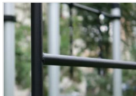
Пример допустимого случая сварного соединения
