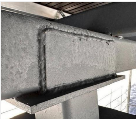
Пример финишной поверхности свай
