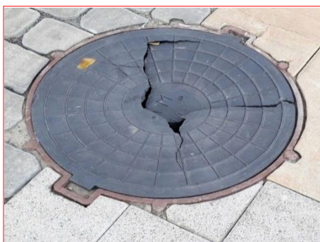
Недопустимы: пластиковые люки на путях движения пешеходов и транспорта
