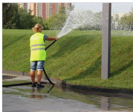
Пример полива рулонного газона после укладки
