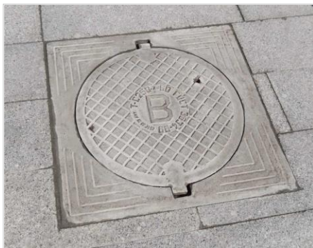
Пример люка «Т»-типа с квадратной обечайкой
