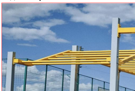
Недопустимы: сварные, болтовые соединения жердей (лестниц) и столбов оборудования площадок для воркаута
