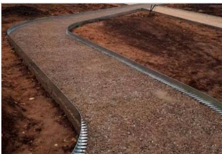
Пример укладки металлического борта
