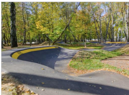
Пример нанесения разметки на памп-треке
