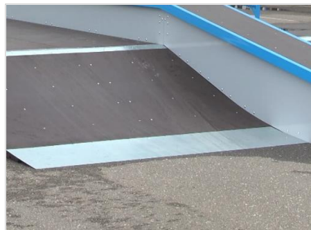
Пример сопряжения отдельно стоящей фигуры с асфальтом
