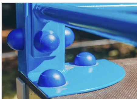
Пример креплений безопасных ограждений
