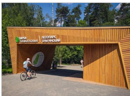
Пример входной группы – малого некапитального сооружения
