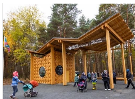
Пример входной группы – малого некапитального сооружения
