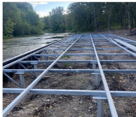
Пример установки свай для настилов
