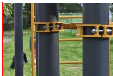
Недопустимы: сварные (не литые) хомуты оборудования для воркаута
