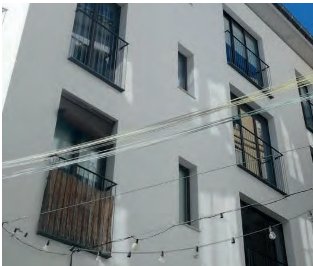
Окраска по штукатурке
