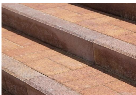
Пример окрашенного в цвет плитки бетонного бордюрного камня
