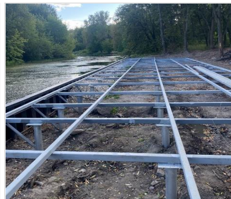
Пример установки свай для настилов
