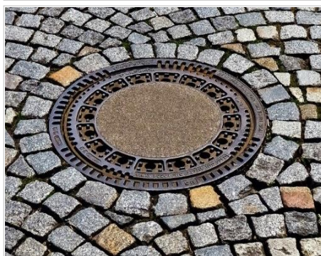
Пример люка «Т»-типа без обечайки
