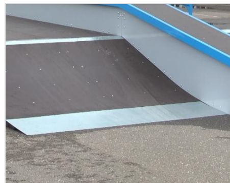
Пример сопряжения отдельно стоящей фигуры с асфальтом
