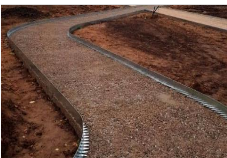
Пример укладки металлического борта
