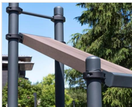
Пример хомутового соединения
