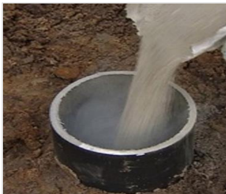
Пример бетонирования свай
