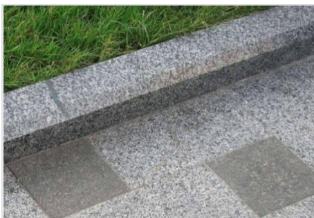
Пример гранитного бордюра с гранитной плиткой
