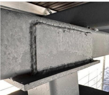
Пример финишной поверхности свай
