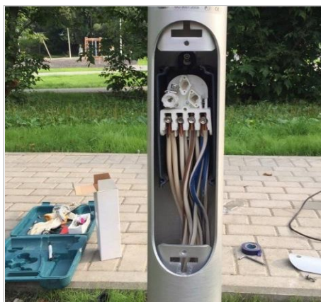
Пример расключения для силовых опор
