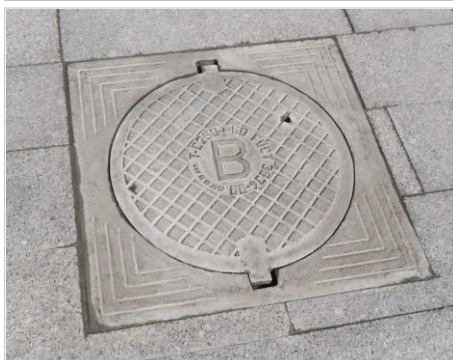
Пример люка «Т»-типа с квадратной обечайкой
