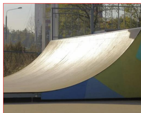
Недопустимы: щели между вертикальными, наклонными поверхностями фигур и покрытием
