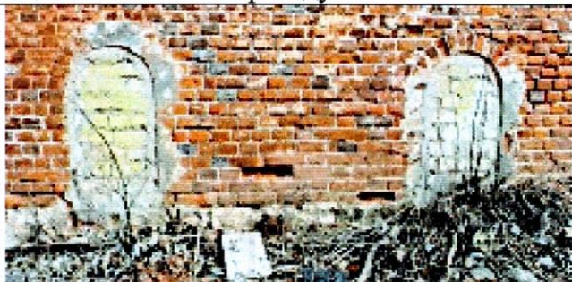
Оконный проем цокольного этажа бокового фасада по ул. Лесозаводской
