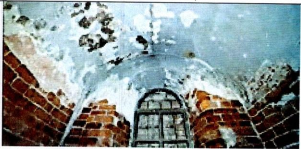
Коробовый свод в цокольном этаже
