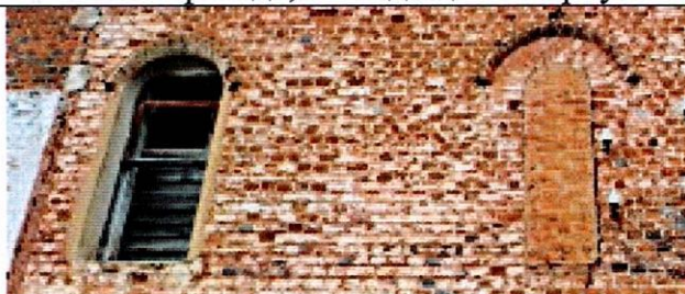
Окна 1 этажа бокового фасада, выходящего в проулок
