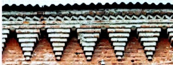
Венчающий карниз по главному фасаду
