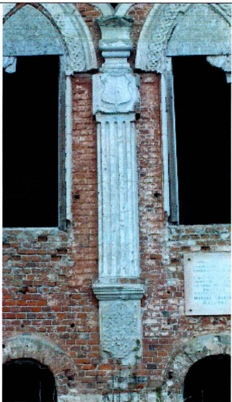
Каннелированная пилястра по главному фасаду
