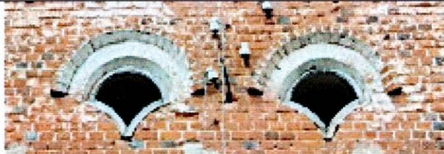
Окна второго света 1 этажа по боковым фасадам
