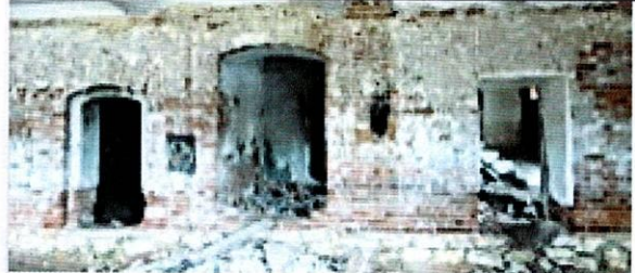
Дверные проемы в цокольном этаже с лучковым завершением
