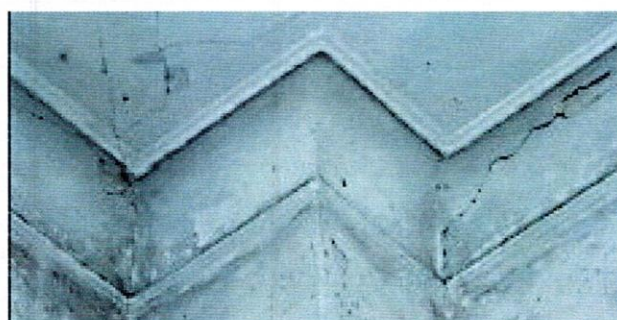
Профилированные потолочные карнизы в интерьере 1 этажа
