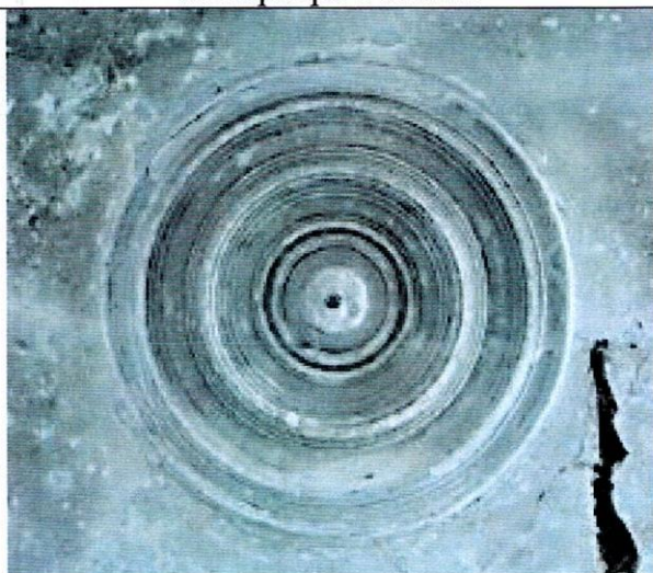
Потолочная розетка в интерьере 1 этажа
