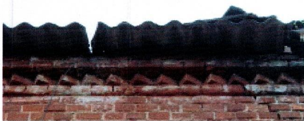
Венчающий карниз по дворовому фасаду
