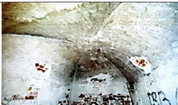
Крестовый свод в цокольном этаже
