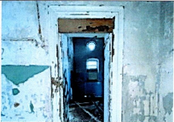
Прямоугольный дверной проем с наличником в коридоре 1 этажа
