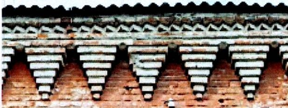
Венчающий карниз по обоим боковым фасадам
