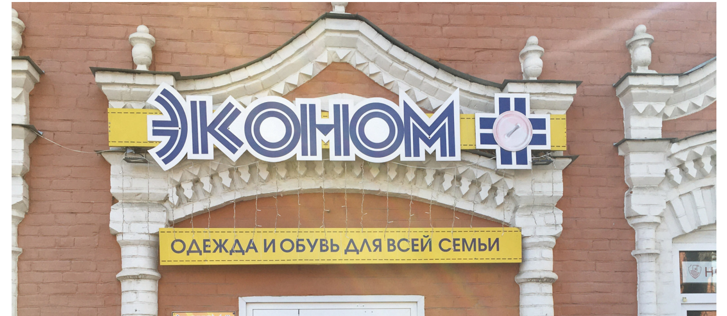
ПЛОХО. Вывеска перекрывает архитектурные особенности фасада
