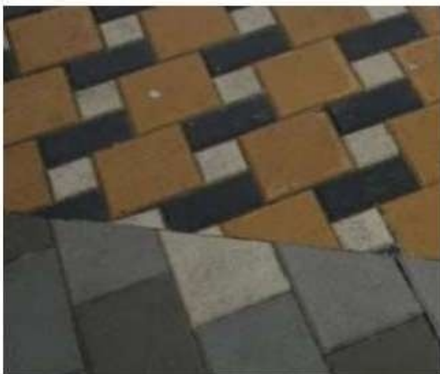
ПЛОХО. Использование покрытий различного цвета и формата, отсутствие элементов сопряжения
