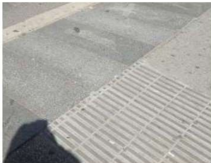
ХОРОШО. Тактильная плитка выполнена из того же материала, что и пешеходная зона
