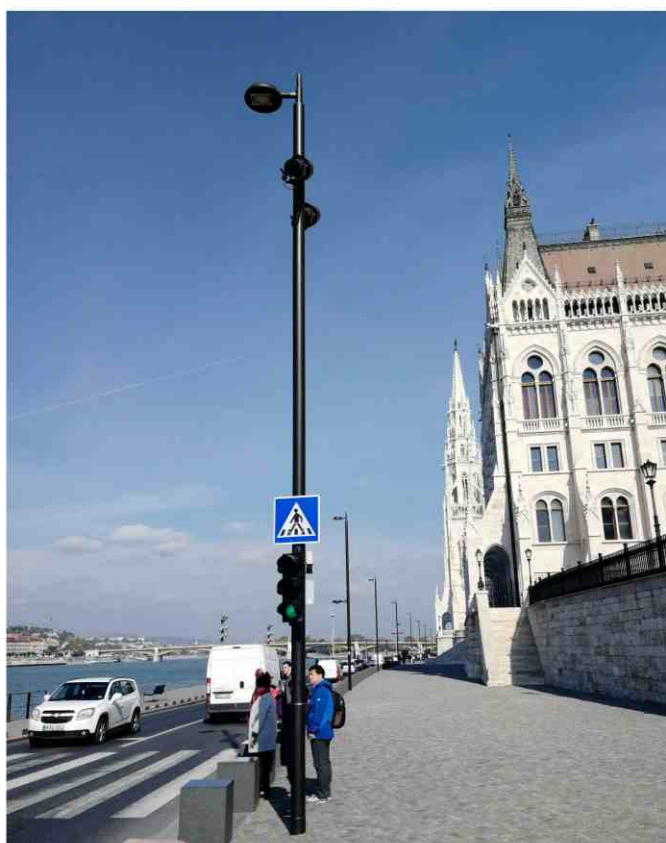
ХОРОШО. Один столб используется для крепления светофора, дорожных знаков и осветительного фонаря
