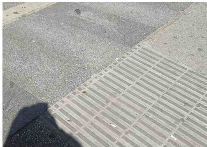
ХОРОШО. Тактильная плитка выполнена из того же материала, что и пешеходная зона
