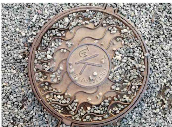
ПЛОХО. На крышке люка скапливается вода и мелкие камни
