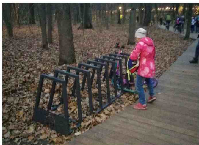
ПЛОХО. Велопарковка располагается на открытом грунте, не учтены габариты велосипедов, которые будут преграждать путь пешеходам
