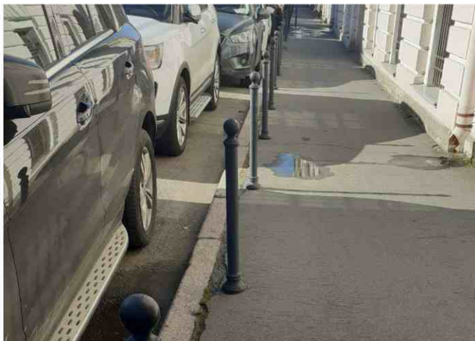
ПЛОХО. Покрытие пешеходного тротуара из асфальтобетона недопустимо
