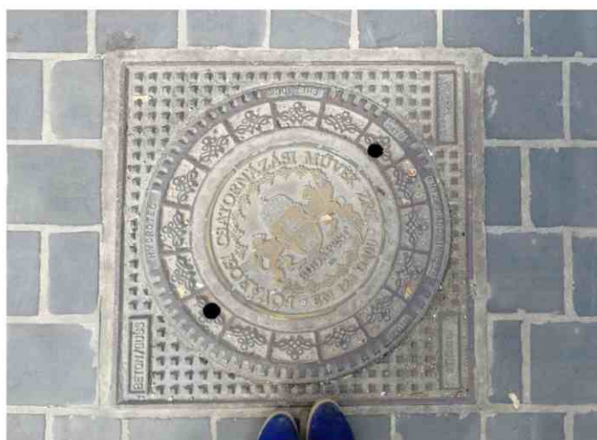
ХОРОШО. На канализационном люке изображен герб города, поверхность рельефная, нескользящая
