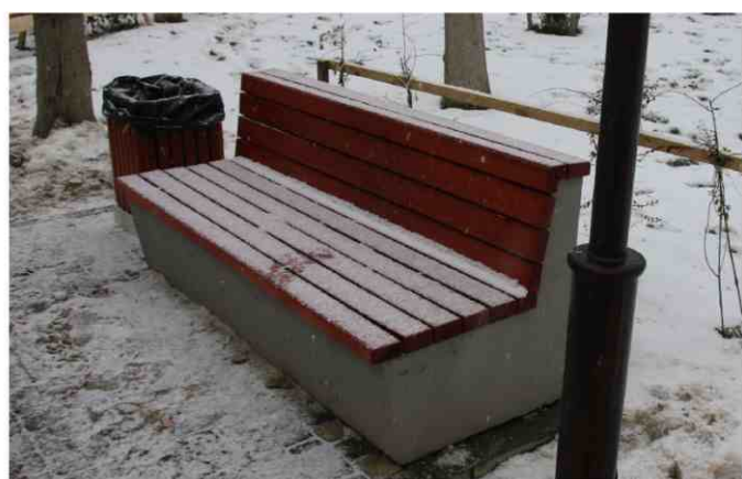
ПЛОХО. Неаккуратно вставлен мусорный мешок
