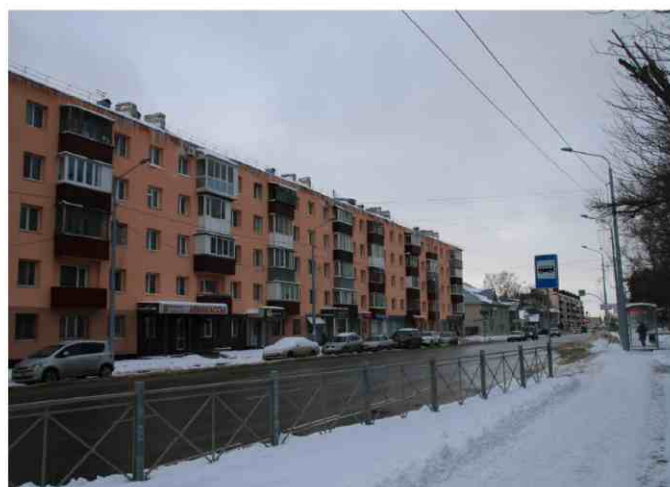
ПЛОХО. Сплошное ограждение препятствует уборки снега
