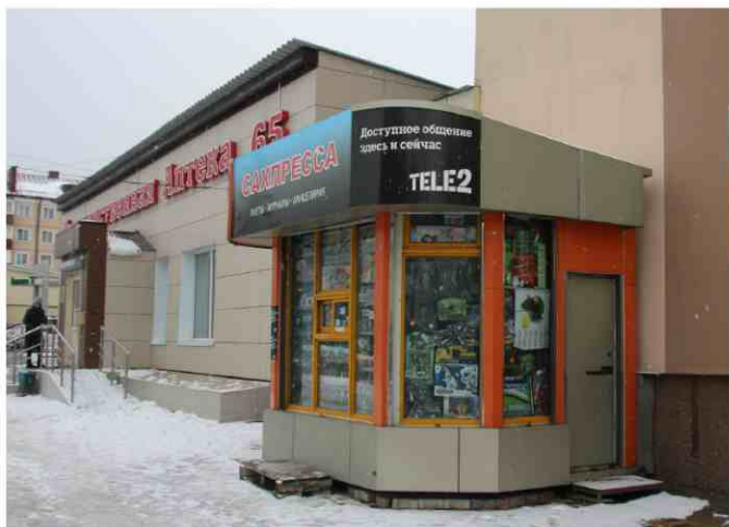
ПЛОХО. Павильон должен размещаться не ближе чем в 10 м от окон зданий
