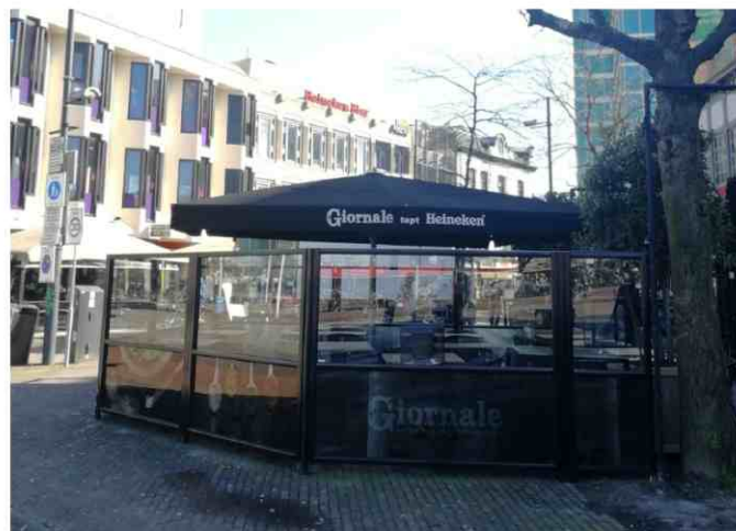
ПЛОХО. Слишком высокое ограждение уличного кафе, рекомендуемая высота — 0,6—0,9 м
