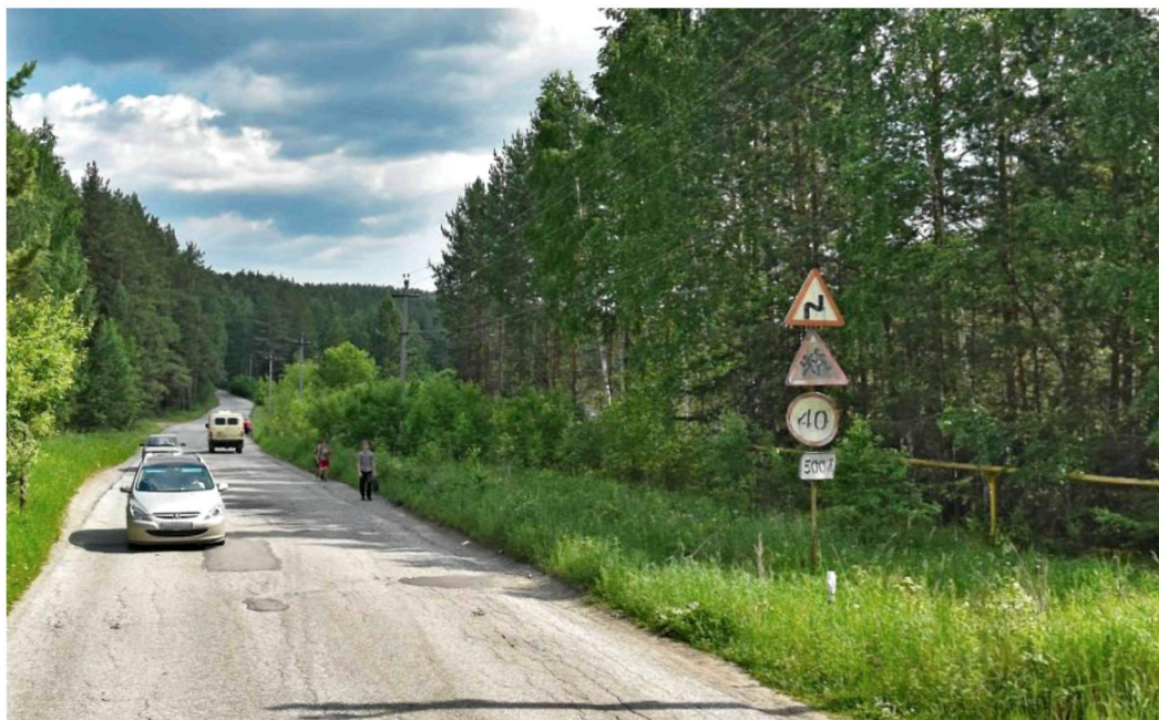
Рисунок 2.7.1 – Состояние знаков по автомобильной дороге к посёлку Золотой пляж
