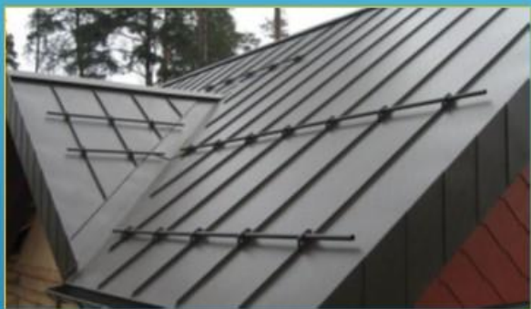
Рисунок 9 – Пример фальцевой металлической кровли
