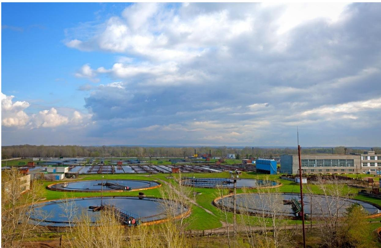
АО «Нижегородский водоканал» эксплуатирует Нижегородскую станцию аэрации. Нижегородская станция аэрации (НСА) — это комплекс сооружений, предназначенный для полной биологической очистки промышленных и хозяйственно-бытовых сточных вод г. Нижнего Новгорода.
