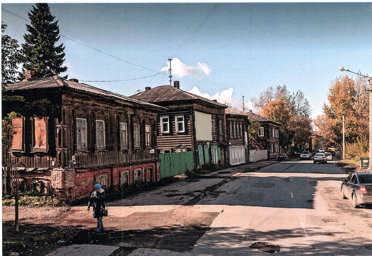
2.57. Вид на застройку ул. Алтайской с пер. Орловского
