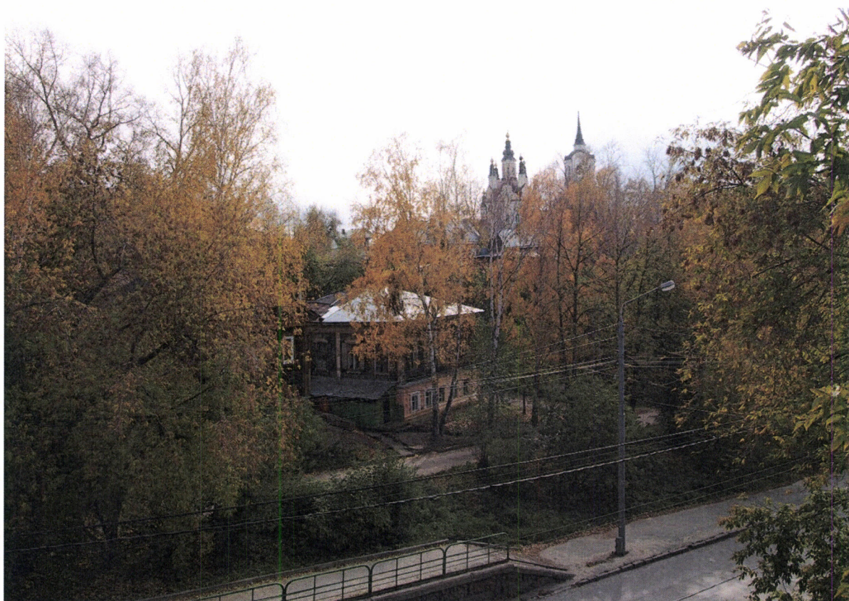
2.36. Вид на Воскресенскую церковь с ул. Кузничный взвоз
